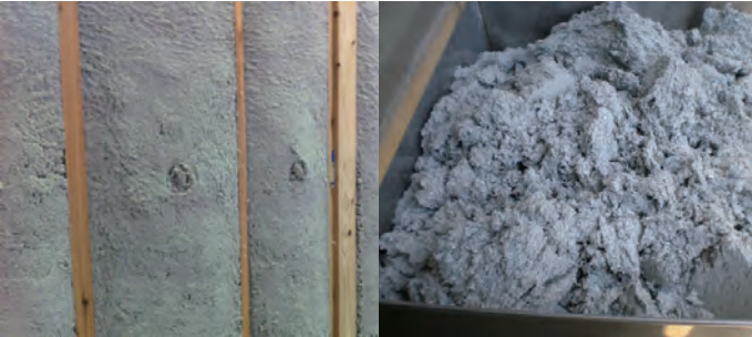
セルロースファイバー断熱（壁）
