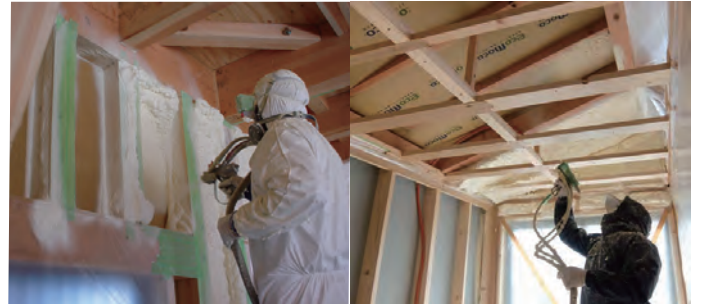
ウレタン断熱（天井・壁）
