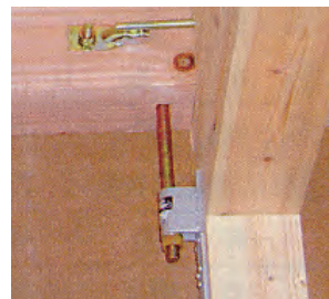
1、2階柱上部ホールダウン金物
